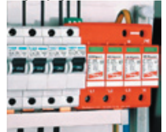
5 pav. Viršįtampių ribotuvai elektros instaliacijoje.
