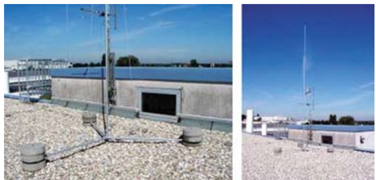
14 pav. Atskirų vertikaliųjų žaibolaidžių, kurių aukštis per 3 m, įrengimas [3]
