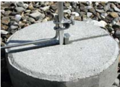
12 pav. Skirtingo aukščio žaibo priėmiklių tvirtinimas prie betoninių atramų [3]
